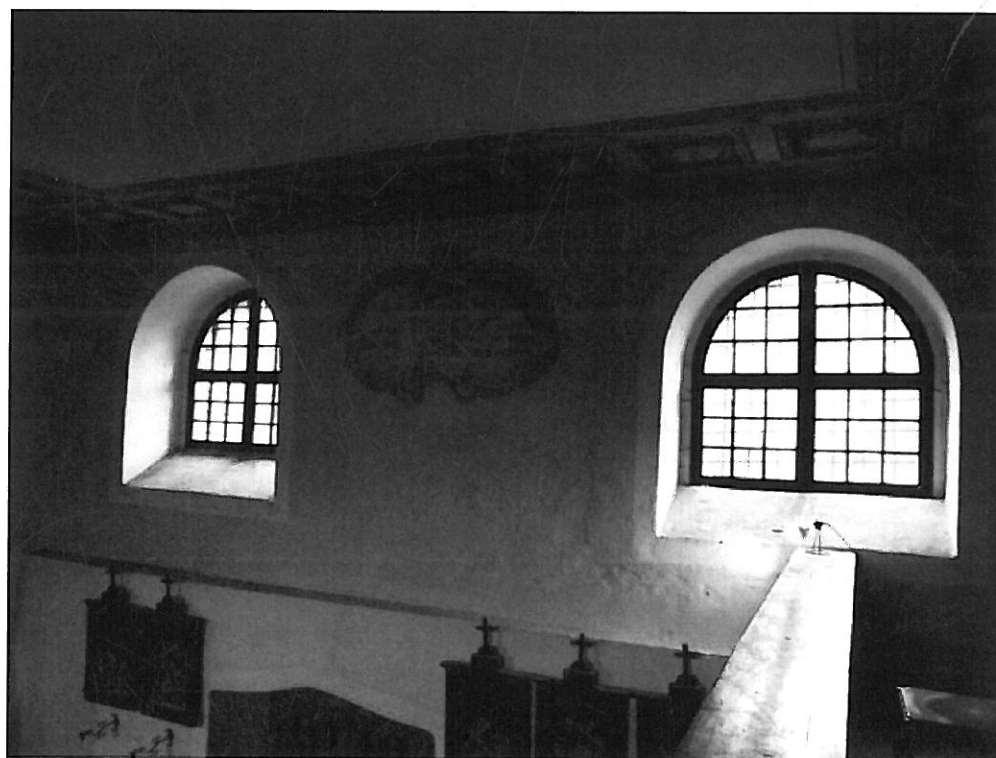
Jižní stěna lodě
